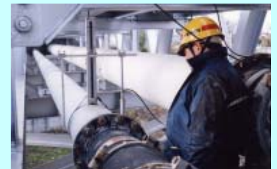
スケールチェッカーによる通水断面積測定
