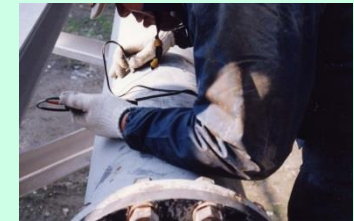
超音波厚さ計による管厚測定
