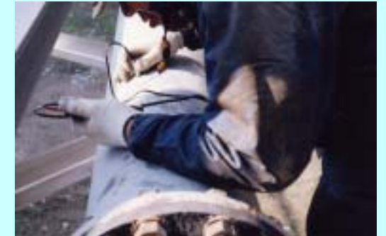
超音波厚さ計による管厚測定
